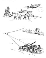
In kürzester Zeit entstanden, von je einer Gruppe gebaut, zwei Karrenfähren von 3 Tonnen Nutzlast, die mit Jeeps und Material den Pendelverkehr über die Aare aufnahmen. In Stilli wurde der Betrieb einer Autofähre von 16 Tonnen Nutzlast besichtigt, welche mühelos der derzeit schwersten Last unserer Armee, einem Panzerjäger, über die Aare half. Diese Fähre wird von einem Pontonierzug mit Ordonnanzmaterial in ca. vier Stundeen gebaut.
