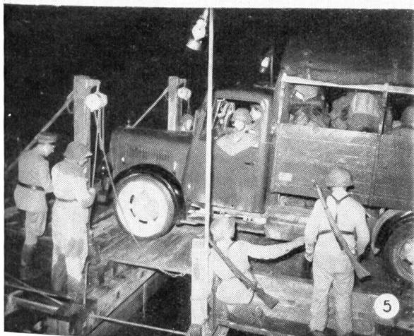
① In strömendem Regen nehmen die Bautruppen des ad hoc aus dem Pontonier-Bataillon 3 und dem Sappeur-Bataillon 7 gebildeten Genie-Regiments 4 den Bau einer der beiden 24-Tonnen-Fähren in Angriff. Am Flussufer sind die Wagen mit den Leichtmetall-Pontons vorgefahren...
