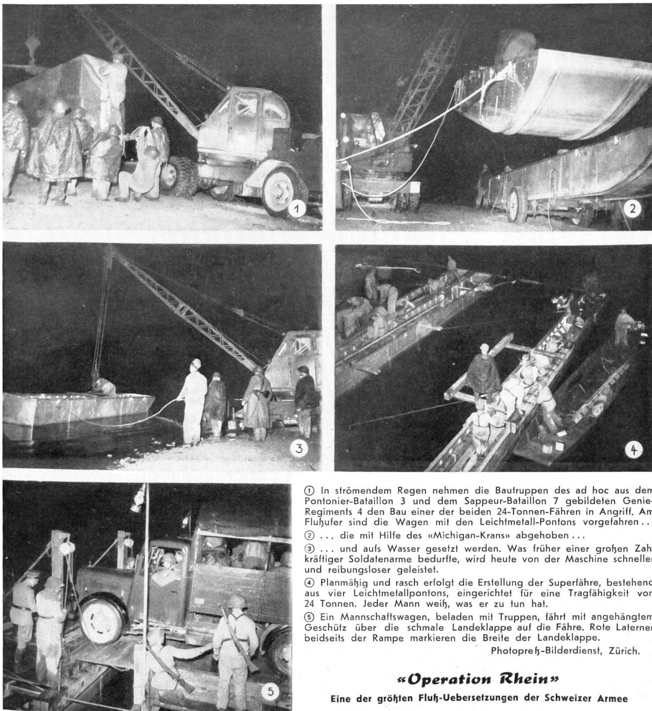
① In strömendem Regen nehmen die Bautruppen des ad hoc aus dem Pontonier-Bataillon 3 und dem Sappeur-Bataillon 7 gebildeten Genie-Regiments 4 den Bau einer der beiden 24-Tonnen-Fähren in Angriff. Am Flussufer sind die Wagen mit den Leichtmetall-Pontons vorgefahren...
