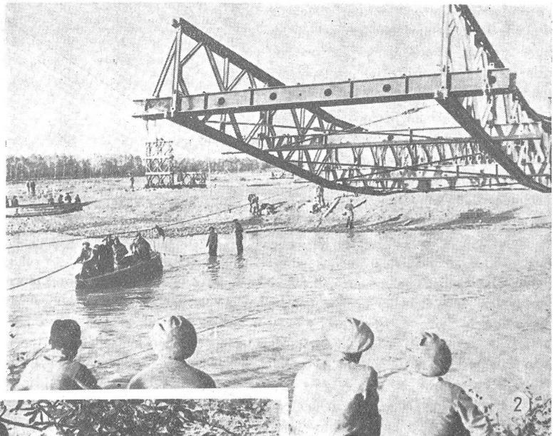
② Die Bailey-Brücke über den Rongo in Italien während des Baues. Wegen Hochwassers konnte kein Pfeiler in der Strommitte errichtet werden. Unter Artillerie- und Mörserbeschuß wurde die Bailey-Brücke über den 54 Meter breiten Wasserlauf geschoben.
