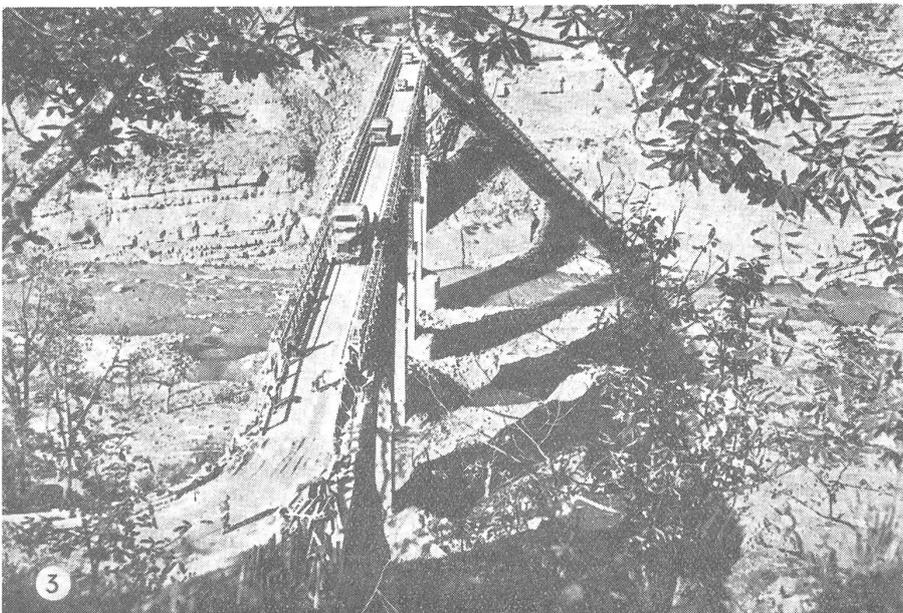
③ Diese Bailey-Brücke ist 160 Meter lang und zwischen 20 und 25 Meter hoch. Sie wurde von Sappeuren der Fünften Armee in Italien errichtet. Der Zeitaufwand ist denkbar gering: Stunden und wenige Tage genügen, wo früher mindestens Wochen und Monate erforderlich waren.
