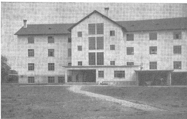
Die Nordfassade mit Eingang und Treppenhaus. Neben dem Eingang das Wachtlokal; am rechten Bildrand der gedeckte Retablierungsplatz.
