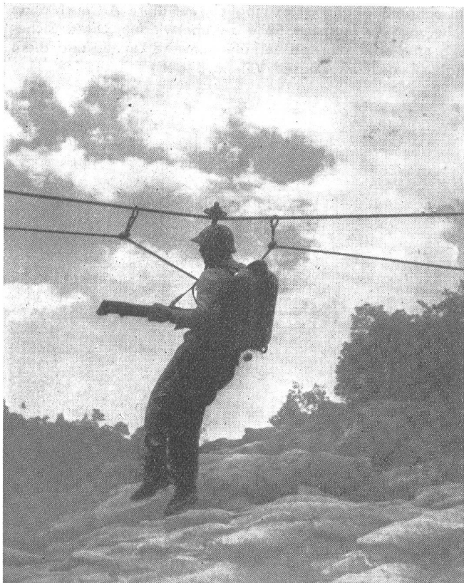
Mannschaftstransport an der «Tyrolienne» mit der Seilrolle. Deutlich sind hier die Sicherheitsschlaufen mit dem freilaufenden Karabinerhaken sichtbar.
