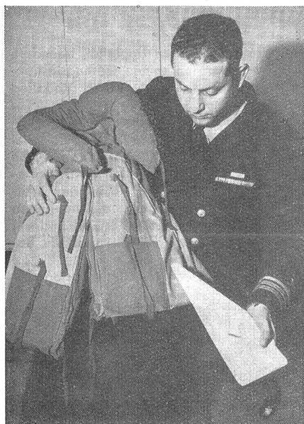
So sehen die Panzerplatten aus gesponnenem Glase aus, die in Westen eingehäutet werden. Der neue persönliche Panzer wurde erst nach dem Kriege in Amerika entwickelt und schützt sicher vor kleinen Kalibern und Granatsplittern. Vorangegangen sind diesen Versuchen Experimente mit den Fliegern bei Okinawa, die Flakschutz-Anzüge aus Nylon, dem neuen Faserstoff, trugen.
