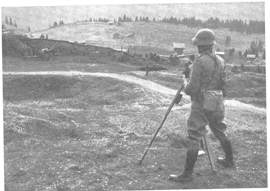
Sicherheitsoffizier einer sch. Batterie überprüft die Batterie-Bereitstellung. (Phot. Egli, Zch.)
