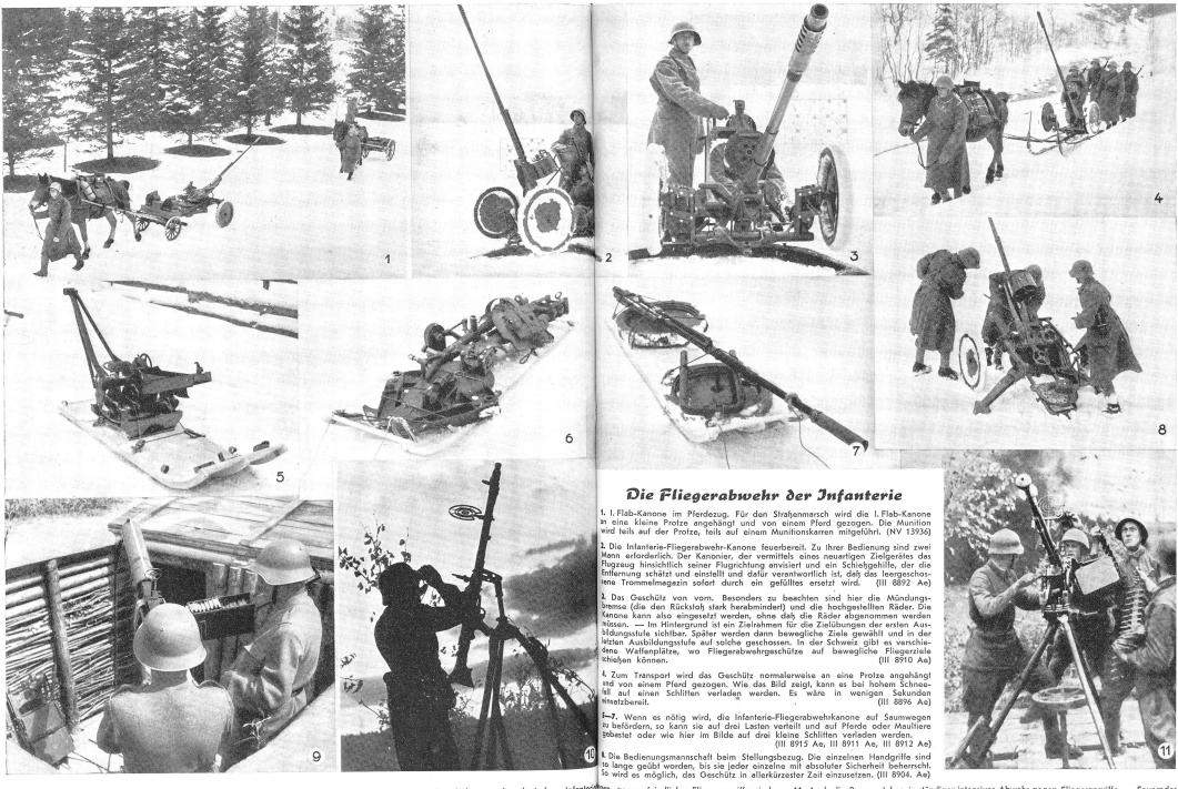
9. Fliegerabwehrposten mit Maschinengewehr 11 auf Flabstütze. Das aufgesetzte ovale Fliegervisier ermöglicht, dem Gewehr den nötigen Vorhalt zu geben.
