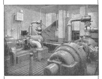
Wasserversorgungs-Pumpen der Stadt Chur  $2 \times 2000$  It/min auf 146 m. Wirkungsgrad =  $81^{\circ}/_{\circ}$
