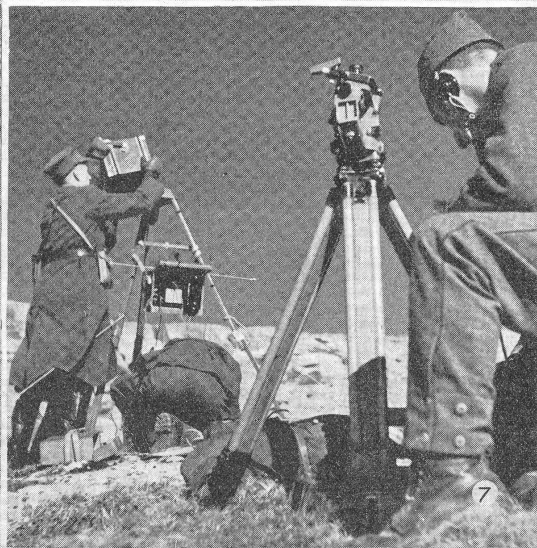
Theodoliten von 30 zu 30 Sekunden der genaue «Standort» der Radiosonde in der Luft gemessen werden. So erhält man von den verschiedenen Luftschichten genaue Angaben bis zur gewünschten Höhe. (N/V 13443)
