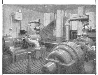
Wasserversorgungs-Pumpen der Stadt Chur  $2 \times 2000$  lt/min auf 146 m. Wirkungsgrad =  $81^{\circ}/_{\circ}$
