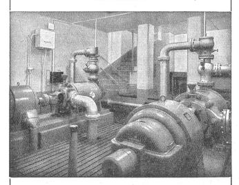
Wasserversorgungs-Pumpen der Stadt Chur  $2 \times 2000$  lt/min auf 146 m. Wirkungsgrad =  $81^{\circ}/o$
