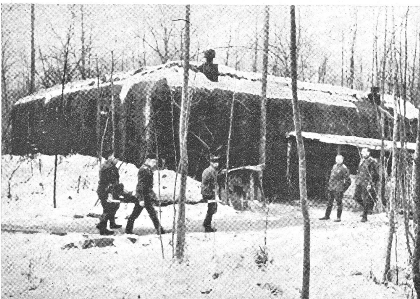
Antransport eines Verwundeten in einen Sanitätsbunker des deutschen Westwall.
