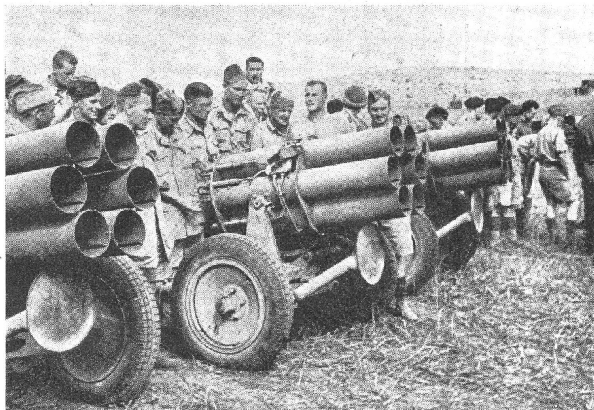
Deutsche Nebelwerfer (Mehrfachgranatwerfer) in Nordafrika von den Alliierten erbeutet. Die Rohre haben ein Kaliber von ca. 18 cm, die Geschosse werden auf elektrischem Wege zum Abschluß gebracht. Nach der Pneubereifung zu schließen, erfolgte der Transport dieser Geschütze durch Motorzug.
