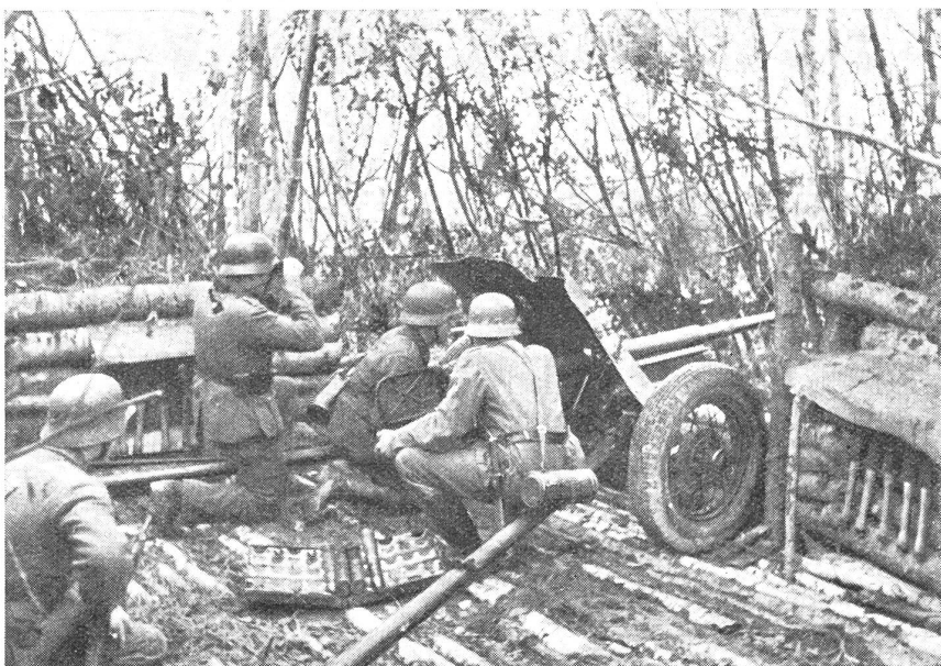
Selbst für die verhältnismäßig leichten Plak-Geschütze mußten im Wolchow-Gebiet Knüppelplattformen erstellt werden.
