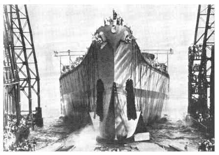
Stapellauf eines neuen Schlachtschiffes von 45,000 Tonnen Wasserverdrängung.
