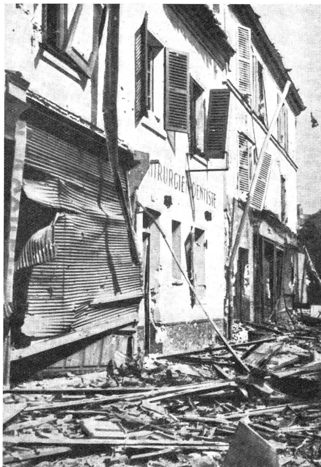
Beispiel der Sogwirkung einer Sprengbombe: Fenster und Fensterladen wurden nach der Straßenseite hin aufgerissen.
