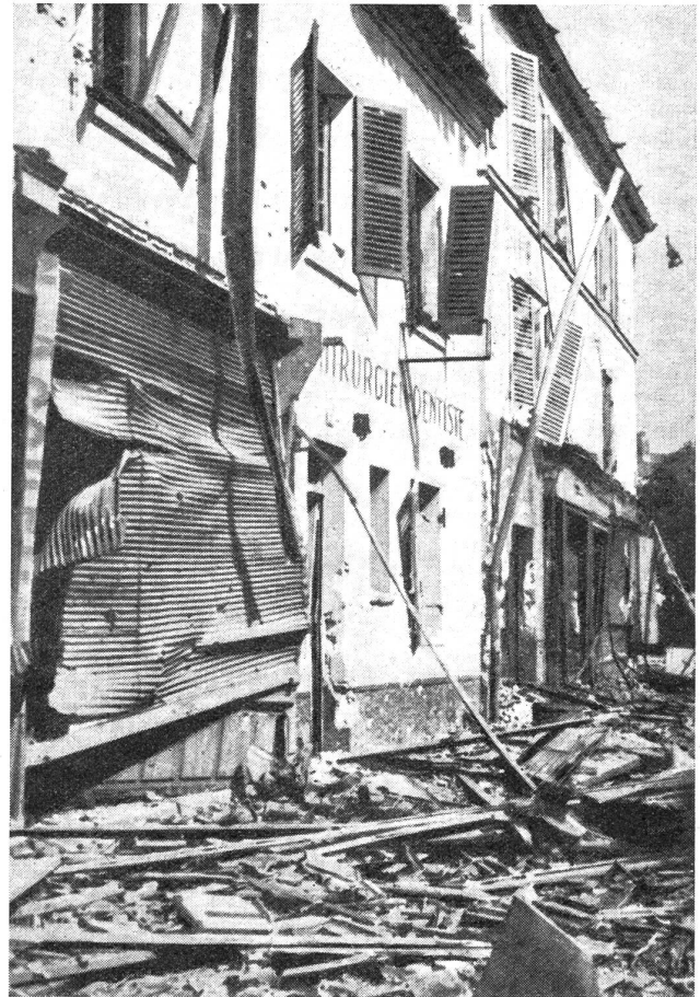
Beispiel der Sogwirkung einer Sprengbombe: Fenster und Fensterladen wurden nach der Straßenseite hin aufgerissen.
