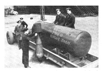
Englische 4-Tonnen-Bombe (ca. 3600 kg). Durch die gerade, kesselartige Form dieser Bomben werden tote Räume in den Bombenflugzeugen weitgehend vermieden. Kopf und Stabilisierungsflächen fehlen bei diesem Bombentyp, dagegen sind rings im Bombenkörper eine Anzahl Zünder eingebaut.
