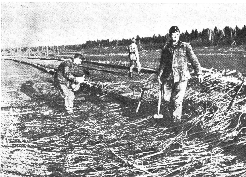
Nur der Knüppeldamm, der Meter um Meter aus gefällten Bäumen und Ästen erstellt werden muß, vermag den Nachschub an die Kampffront zu sichern.
