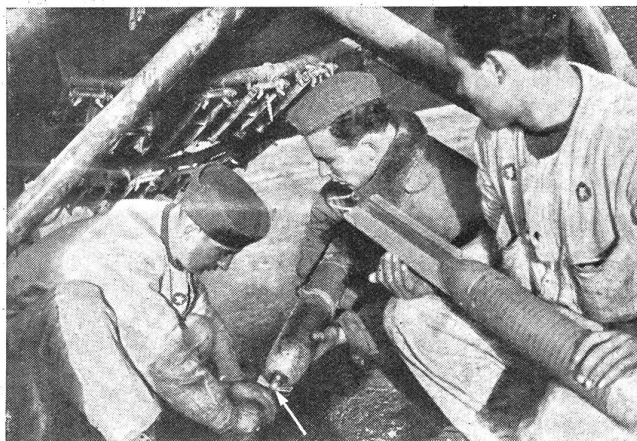
Kleine italienische Minenbomben mit dreiteiligen Flügelrädchen an der Bombenspitze. Vermutlich handelt es sich bei dieser Bombenart um Panklastitbomben mit höchster Sprengwirkung.
