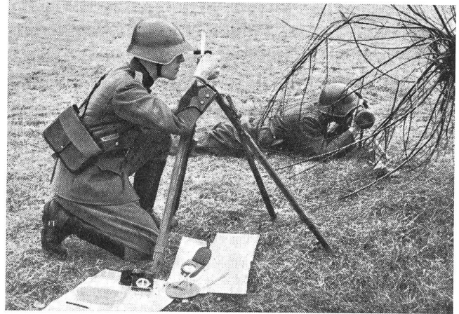
Photographie Nr. 1: Zens.-Nr. IX b B 3096. Die Richtstelle , wo der Zugführer mit Richtkreis, Flugbahnkarte, Mefydreieck, Thermometer, Barometer, Karte, Flugbahnkarte und event. Kompaß seine Berechnungen macht. Zur Bestimmung der Distanz hat er den Telemetermann bei sich.
