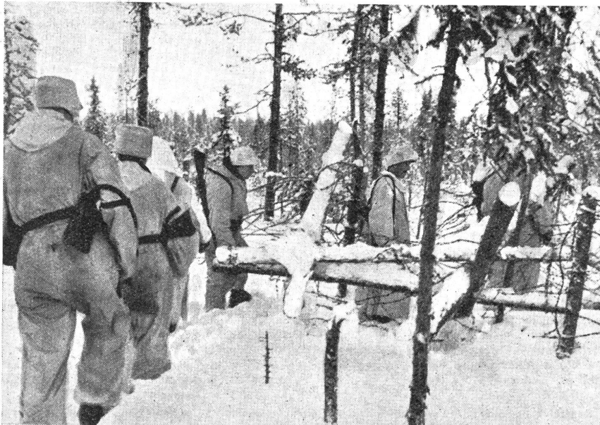
... und passiert kurz darauf die im lichten Wald ausgelegte Drahtsperr.
