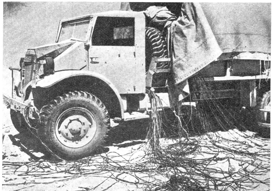
Die mobile «Nervenzentrale». Irgendwo auf dem Kriegsschauplatz in der ägyptischen Wüste ist die Telephonzentrale eines hohen englischen Kommandostabes auf einem gewöhnlichen Motorlastwagen installiert, wodurch eine rasche Dislozierung der für die Kampfführung so wichtigen Apparaturen gewährleistet ist.
