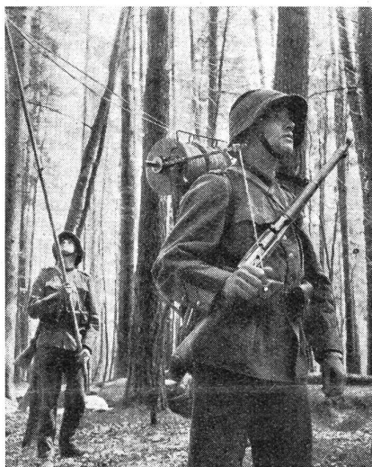
Inf.-Tf.-Patr. beim Bau einer zweidrähtigen Leitung. (Z.-Nr. III Gr 6338.)
