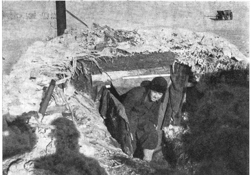
Italienischer Unterstand in der Ebene des Donezbeckens.
