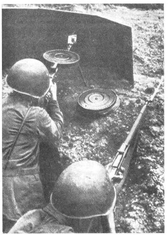
Das Djegtjarew-Lmg. Mod. 1930. Gasdrucklader mit Luftkühlung; Patronenzufuhr aus Trommel zu 49 Schuß; Feuergeschwindigkeit 600 Schuß pro Minute; Gewicht 9,4 kg. Der im Bilde sichtbare Schutzschild ist improvisiert.
