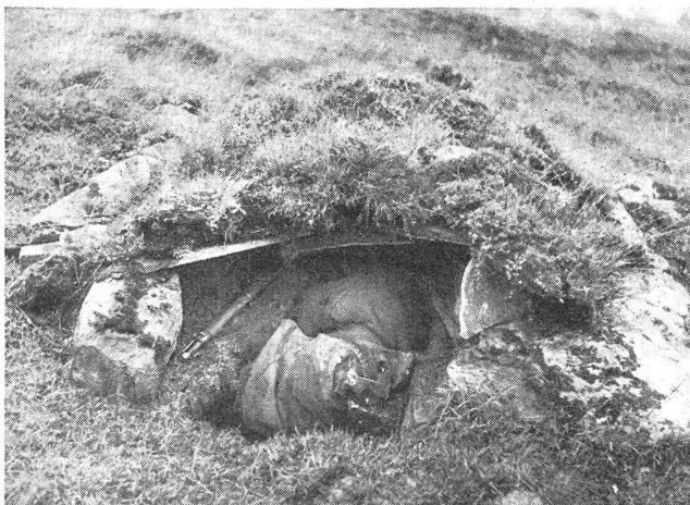
Gefarntes Erdloch, von der dem Feinde abgekehrten Seite gesehen; durch einige wenige weitere Rasenziegel kann nötigenfalls auch noch der Einschlupf gegen Luftbeobachtung von hinten gefarnt werden. (Zens.-Nr. VI Vi 11622.)
