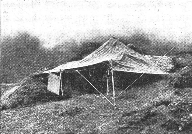
Vorgeschobener Beobachtungsposten. Die Tarnung mittels tarnbemalten Zelteinheiten ist gegen Beobachter-Photographie ungenügend, da die Zelte als helle Flecke wiedergegeben werden. Auflegen von Aesten notwendig. (Zens.-Nr. VI Vi 11625.)
