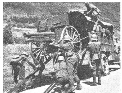
Durch Verlastung der nicht gummibereiteten Feldgeschütze kann deren Marschgeschwindigkeit ohne Nachteil für die Schußpräzision auf 35 St/km gesteigert werden. (Z.-Nr. VI Vi 11621.)
