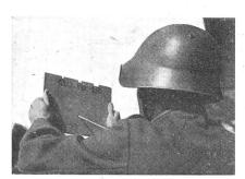
Ein einfaches Mittel zur Feststellung der Schuftdistanzen gegen Flugziele: mittels einer am obersten Waffenrockknopf eingehängten Schnur von 50 cm Länge wird festgestellt, in welche Kerbe das Flugziel hineinpaßt. Bei einer Flugzeuglänge von 10 m entspricht die 0,5-cm-Kerbe einer Entfernung von 1000 m, die 1-cm-Kerbe einer solchen von 500 m und die 2-cm-Kerbe einer solchen von 250 m. (A/Er/316.)
