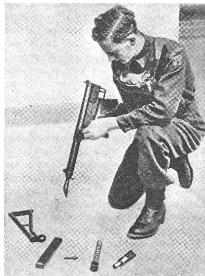
Die Hauptbestandteile der «Sten»-MP. (von links nach rechts): Anschlaggestell, Magazin, Schlagstift, Schlagfeder und Verschluss. Der Pistolenschaft ist mit einem Feuerschneidring versehen.
