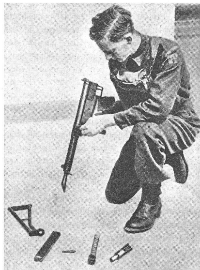
Die Hauptbestandteile der «Sten»-MP. (von links nach rechts): Anschlaggestell, Magazin, Schlagstift, Schlagfeder und Verschluss. Der Pistolengriff ist mit einem Feuerscheindämpfer versehen.
