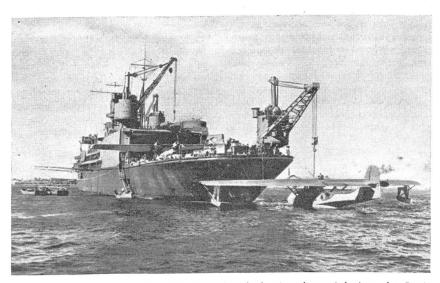
Amerikanisches Flugzeugmutterschiff für große Flugboote; eben wird eines der Boote mittels des Hebekranes an Bord genommen. — Porte-avions américain pour grands avions; l'un de ceux-ci est précisément chargé à bord au moyen d'une grue. — Nave madre americana per grossi idroplani; un apparecchio viene appunto sollevato a bordo.
