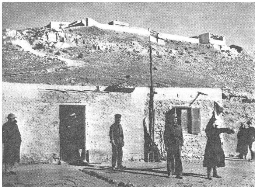
Die Zitadelle von Tobruk mit einer englischen Ufer-Signalstation.
