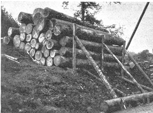
Vorbereitetes improvisiertes Tankhindernis, durch Sprengung der Verstrebungen werden die Baumstämme die Straße versperren. — Obstacle anti-tank improvisé: un barrage de troncs d'arbres est provoqué par explosion. — Ostacolo anticarro improvvisato preparato; i tronchi d'albero sbarreranno la strada. (Z.-Nr. N/V/10039.)
