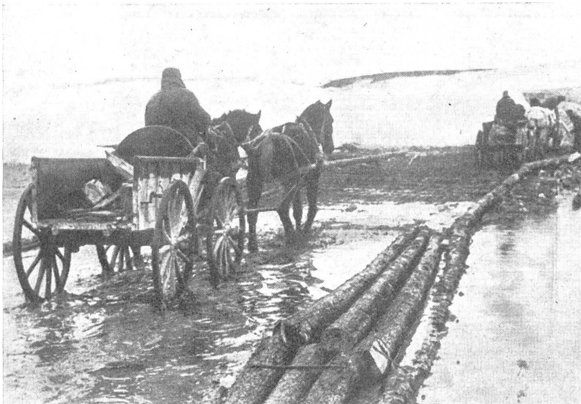
Durch Knüppelwege wird an der russischen Front zur Zeit der Schneeschmelze der Fuhrwerkverkehr aufrechterhalten. — Sur le front russe, pendant la période de fonte des neiges, le trafic routier peut être maintenu grâce à des chemins de rondins de bois. — Il traffico dei veicoli viene mantenuto in Russia durante il periodo dello scioglimento delle nevi mediante assi e traversi.
