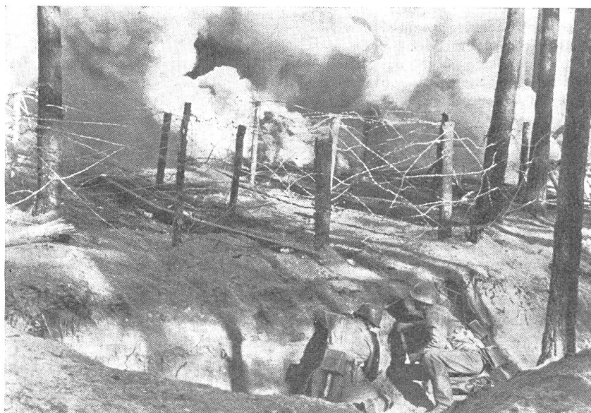
Unter dem Schutze von Nebelkerzen arbeitender deutscher Drahtsperr-Sprengtrupp. Zur richtigen Deckung der Arbeit sind die Nebelkerzen in und feindwärts des Hindernisses geworfen. — Détachement de destruction allemand travaillant sous la protection de fumées artificielles. Pour que les hommes effectuant le travail soient bien à couvert, les boîtes à fumée doivent être lancées dans la partie de l'obstacle qui fait face à l'ennemi. — Squadra di guastatori tedeschi al lavoro sotto la protezione di candele nebbiogene. Per mascherare completamente il lavoro, le candele fumogene sono state gettate nell'ostacolo e verso il nemico.
