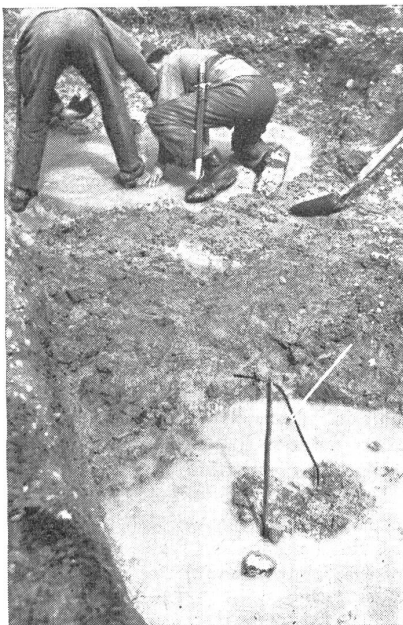
Einbau von bedienten Minen mit Zündschnurzündung. — Installation de mines avec cordons d'allumage. — Applicazione di micce d'accensione a mine pronte. (Zens.-Nr. VI R 10168.)
