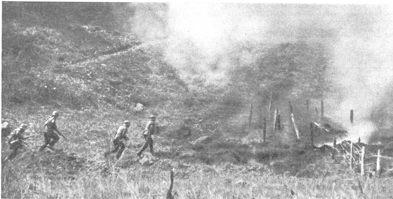
Der Einbruch durch das gesprengte Hindernis. — L'obstacle a sauté et la troupe se précipite dans la brèche. — Si penetra nell'ostacolo distrutto. (Zens.-Nr. VI Br 2389.)
