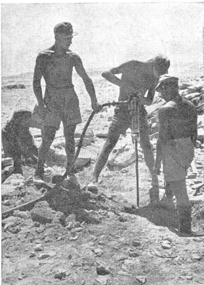
Mühsamer Stellungsbau in der nordafrikanischen Wüste. — Pénible construction de positions dans le désert nord-africain. — Faticoso lavoro di costruzione nel deserto nordafricano.
