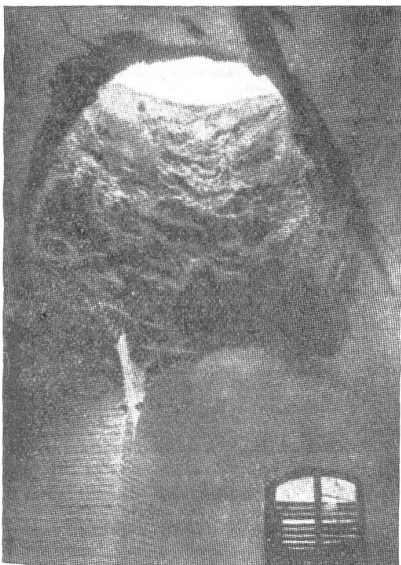
Die Wirkung der «Dickten Berta»: Durchschlag einer 42-cm-Granate in der Decke eines belgischen Forts. — L'efficacité de la «Grosse Bertha»: impact d'un obus de 42 cm. sur la dalle d'un fort belge. — L'effetto della «Dicke Berta»: percussione di una granata da 42 cm. sul tetto di un forte belge.
