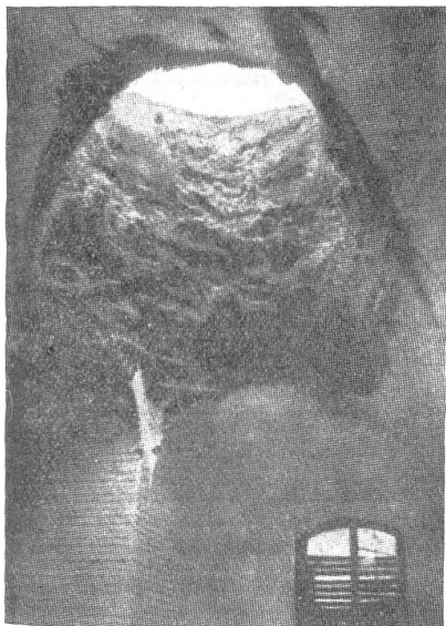
Die Wirkung der «Dickten Berta»: Durchschlag einer 42-cm-Granate in der Decke eines belgischen Forts. — L'efficacité de la «Grosse Bertha»: impact d'un obus de 42 cm. sur la dalle d'un fort belge. — L'effetto della «Dicke Berta»: percussione di una granata da 42 cm. sul tetto di un forte belga.
