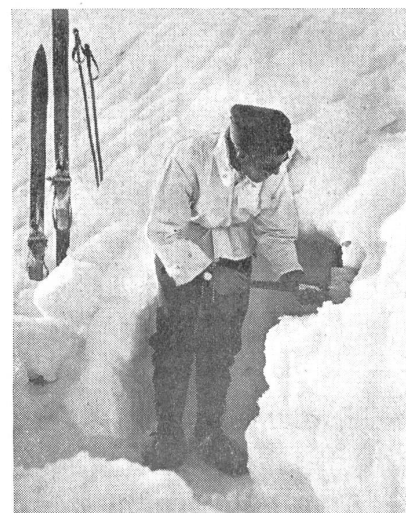
Aushub einer Schneehöhlen-Unterkunft für eine Gipfelbesatzung auf 4000 m ü. M. im rückwärtigen Firnhang. — Etablissement d'un cantonnement dans la neige à 4000 m d'altitude. — Lo scavo di una caverna nella neve, che servirà da ricovero per un presidio a 4000 m. s. m. (Zens.-Nr. VI H 4941.)
