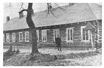
Deutsches Winterquartier im Osten. Zwischen äußerer Balkenwand und innerer Holzverschalung dieser Blockhäuser ist eine dichte isolierende Moosschicht eingepreßt. Die
