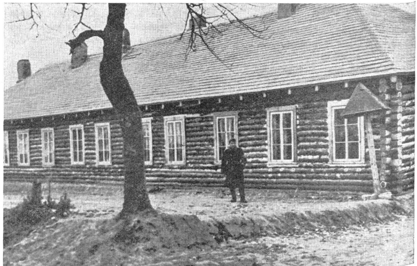
Deutsches Winterquartier im Osten. Zwischen äußerer Balkenwand und innerer Holzverschalung dieser Blockhäuser ist eine dichte isolierende Mooschicht eingepreßt. Die Dächer bestehen aus Schindeln. — Quartier d'hiver allemand dans l'Est. Entre les parois extérieures en poutres et le revêtement intérieur en planches de ces blockhaus, se trouve une couche épaisse de mousse pressée faisant fonction d'isolant. Les toits sont en bardeaux. — Quartiere invernale tedesco in oriente. Fra la parete esterna ed interna vi è un vano speciale isolante. Il tetto è di paglia.
