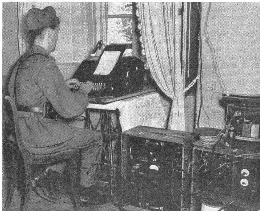
Der Fernschreiber , das moderne Drahtverbindungsmedium der höheren Stäbe. — Le téléscripteur , le moyen moderne de liaison des états-majors supérieurs. — La telescrivente , il moderno mezzo di trasmissione degli ordini negli stati maggiori superiori. (Zens.-Nr. VI K 136.)
