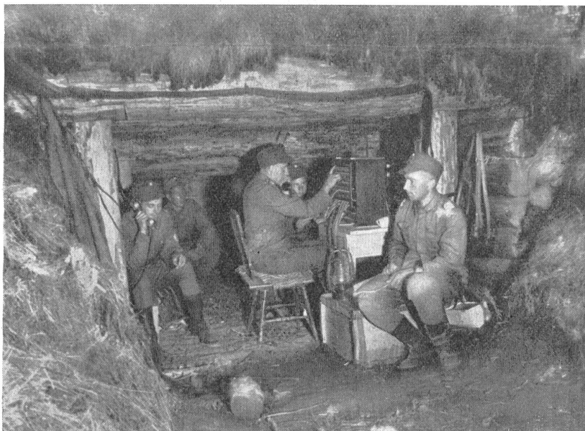
Finnische Regiments-Telephonzentrale in einem splittersicheren Gefechtsunterstand an der ostkarelischen Front. — Centrale téléphonique de régiment finlandaise dans un abri résistant aux éclats, sur le front oriental de Carélie. — Centrale telefonica di un reggimento finlandese in un ricovero a prova di granate sul fronte della Carelia orientale.
