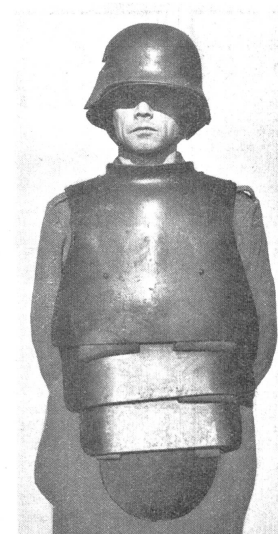
Deutsche Grabenausrüstung vom Hartmannsweilerkopf (Vogesen): vierteiliger Brust- und Bauchpanzer gegen Direkttreffer und verstärkter Stahlhelm.
