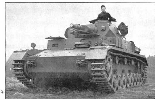
Bild 8. Schwerer Panzer-Kampfwagen (5 Mann Besatzung; 6 Doppellaufräder; Bewaffnung: 1 Geschütz von min. 7,5 cm und mehrere Mg.).
