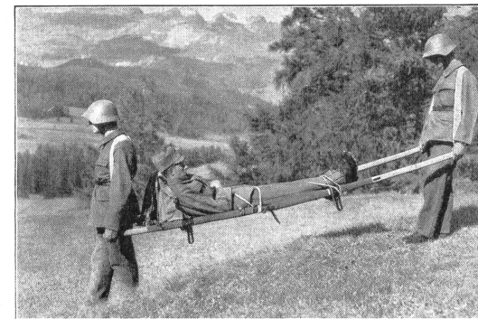
Rechts: Verlängerte Tragholme an der hinteren Bahnhälfte erlauben dem hinteren Träger durch die bessere Terrainsicht sicheres Gehen.
