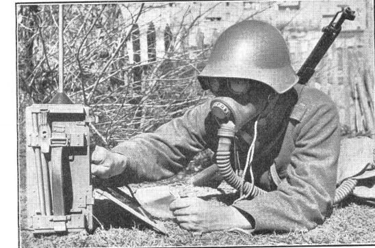
Auch das Gas kann die Übermittlung nicht stören, dank dem Kehlkopfmikrofon kann auch unter der Gasmaske gesprochen werden. (A Er 551.)
