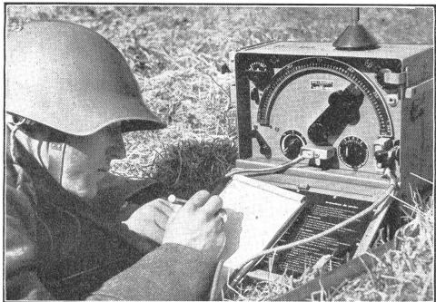
Die Frontplatte des Patrouillen-Sende- und Empfangsgerätes mit den verschiedenen Schaltern für Telefonie und Telegrafie, Senden und Empfang, sowie der Frequenzskala. (Zensur-Nr. A Er 553.)
