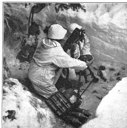
Minenwerfer-Gruppe bei der künstlichen Entladung eines Lawenhangs durch Wurfgranaten. (A Er 531.) Lance-mine tirant contre une pente neigeuse pour provoquer artificiellement la chute d'une avalanche. Con tiri di lanciamine si provoca la caduta di una valanga che minaccia il pendio.
