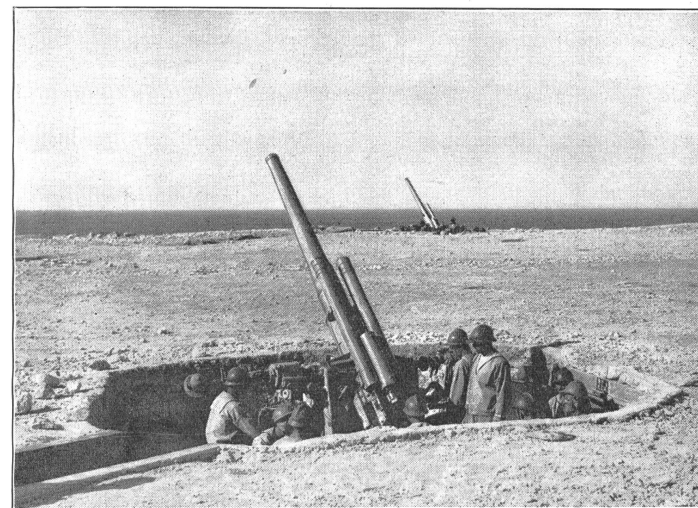
Italienische 10,2-cm-Flabatterie M. 29 (System Orlando) für Küstenverteidigung. Geschößgewicht 15 kg; V^0 900 m/sec; Reichweite nach der Höhe 10 km, Weite 15 km.
