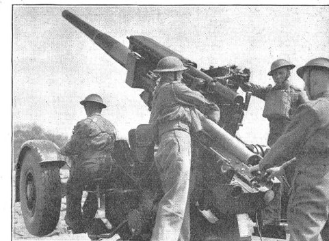
Rechts: Englisches 9,4-cm-Flabgeschütz, Konstruktion Nottingham, für mobile Fliegerabwehr. Nach Auslegen der Kreuzlafette können die Räder entlastet werden. Gesamtgewicht und V^0 unbekannt; Geschößgewicht 12,6 kg, mit einer Reichweite von 12 km nach der Höhe.
