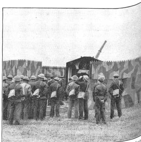
Englisches 11,4-cm-Flabgeschütz, System Nottingham, für ortsfeste Flab. Gewicht der Geschosse zirka 20 kg; Feuergeschwindigkeit 10 Schuß pro Minute. Weitere Angaben derzeit nicht erhältlich.
