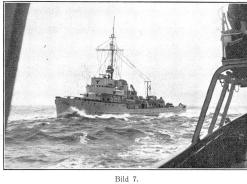
Als Zerstörer bezeichnet man ungepanzerte Kriegsschiffe mit Ge-schwindigkeiten von 36 und mehr Knoten, deren Hauptwaffe aus 6 und mehr Torpedorohren besteht. Die Größe dieser Schiffe schwankt zwischen 900 und 1800 tons Wasserverdrängung. Bild: Deutscher Zerstörer in der Nordsee.
